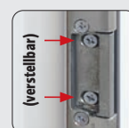
Sicherheits- Mittelschließblech (verstellbar)
